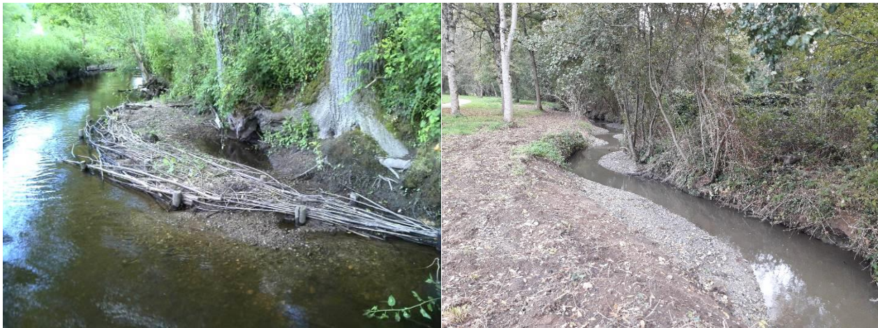
Diversification du lit par risberme végétale et minérale – Source : Hardy Environnement
