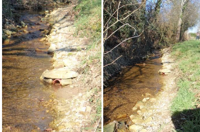
Allongement d'un drain en complément d'une opération de rehaussement du lit – Source Hardy Environnement
