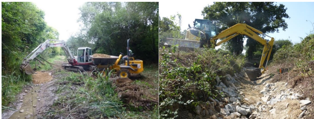
Recharge granulométrique de cours d'eau – Source: CAP Atlantique
