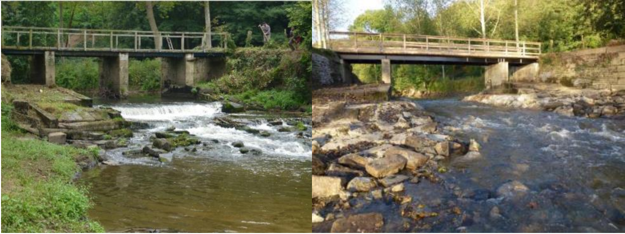
Arasement de seuil et construction d'une passerelle sur le Couesnon – Source : Bretagne Grand Migrateur & Fédération départementale de pêche 35
