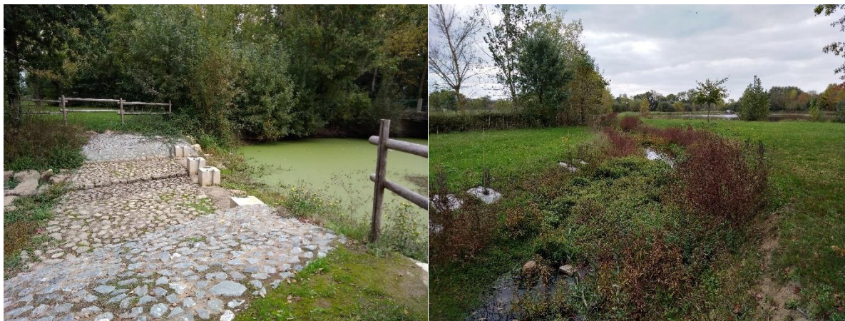
Répartiteur de débit et bras de contournement au Mesnil-en-Vallée (49) – Source : Hardy Environnement
