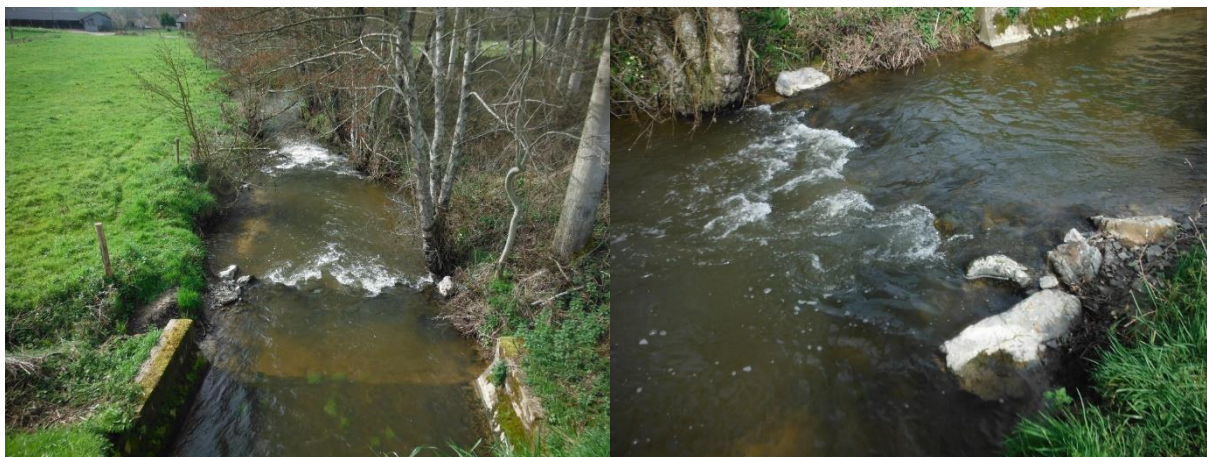
Aménagement de mico-seuils successifs – Source : Hardy Environnement
