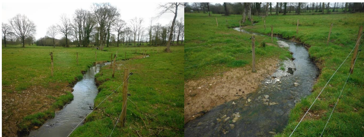
Remise d'un cours d'eau dans son talweg sur le bassin versant du Couesnon aval – Source : Hardy Environnement
